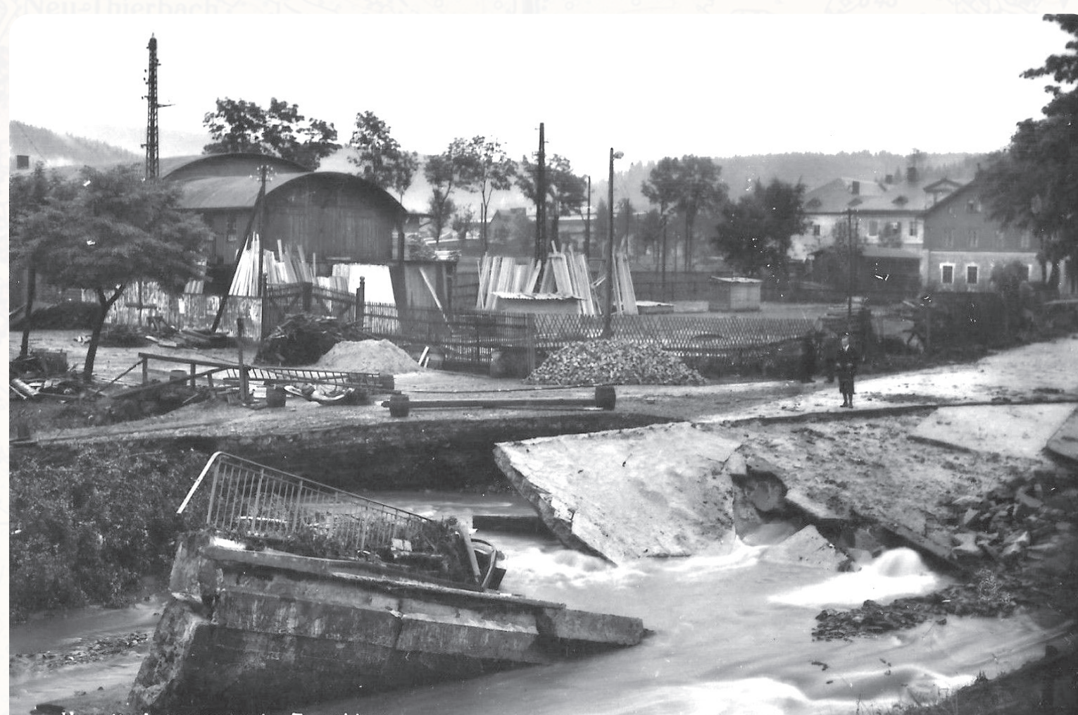
Stržený most přes Černou ve Wittigsthalu za česko-německou hranici v Potůčkách po povodni 6. července 1931. Die abgerissene Brücke über das Schwarzwasser in Wittigsthal, jenseits der tschechisch-deutschen Grenze in Potůčky (Breitenbach) nach dem Hochwasser am 6. Juli 1931.
