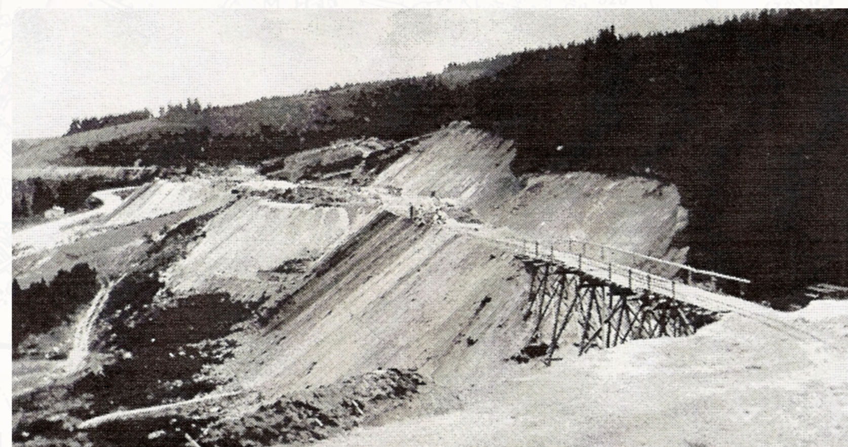
Výstavba trati z Karlových Varů do Potůček si vyžádala obrovské terénní úpravy – na snímku budování viaduktu v Perninku před rokem 1899. Der Bau der Strecke von Karlsbad nach Potůčky erforderte umfangreiche Landschaftsgestaltung – auf dem Foto der Bau des Viadukts in Pernink vor 1899.
