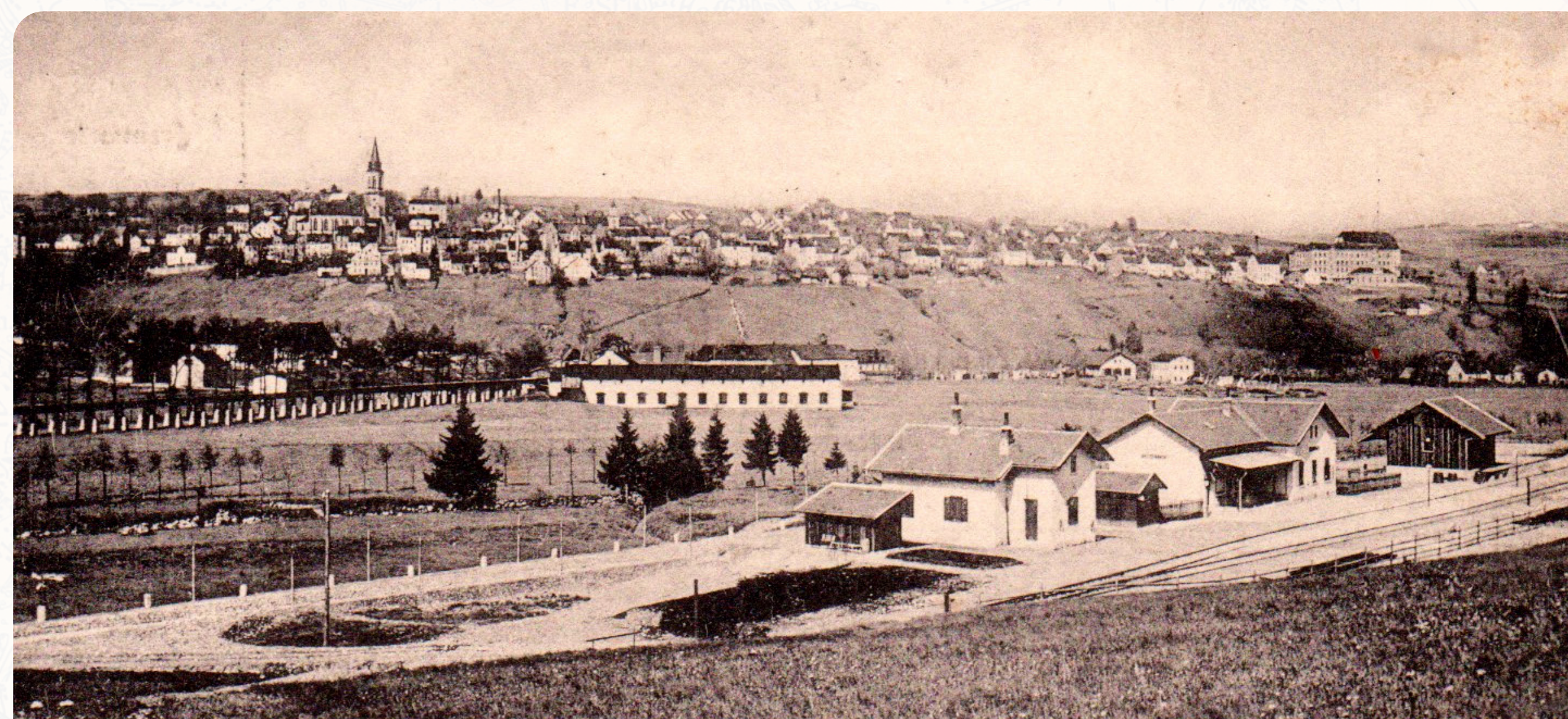
Železniční stanice v Potůčkách v roce 1899, krátce po zprovoznění trati Karlovy Vary – Johannegeorgenstadt, vlečka do železáren (uprostřed snímku) tehdy ještě neexistovala. Die Eisenbahnstation in Potůčky im Jahr 1899, kurz nach der Eröffnung der Strecke Karlsbad – Johannegeorgenstadt. Das Anschlussgleis zum Eisenwerk (in der Bildmitte) existierte zu diesem Zeitpunkt noch nicht.
